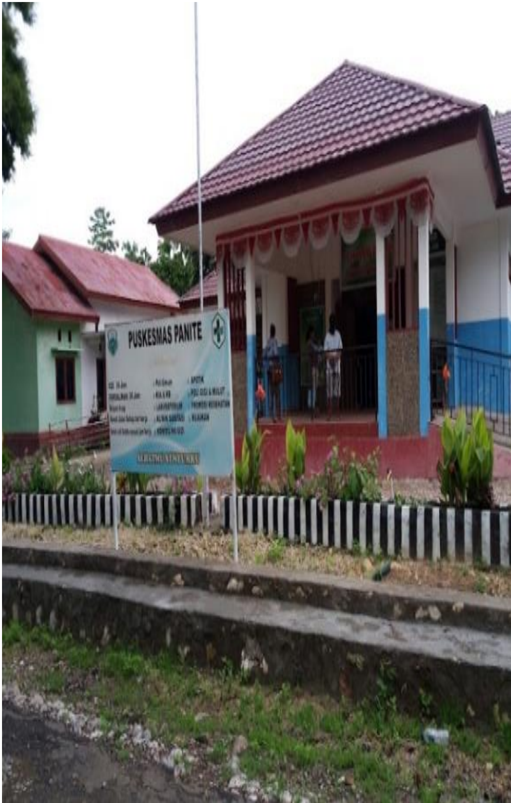
Gambar Gedung Puskesmas Panite
